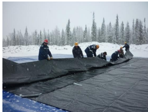
Складывание резервуара
