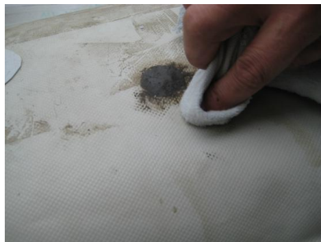
Обезжиривание поверхности на резервуаре
