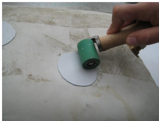
Накладываем и прижимаем кусочек полимерного материала
