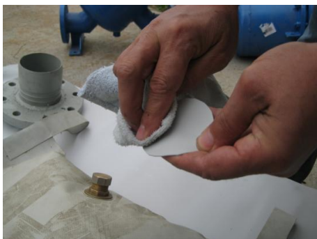
Обезжиривание кусочка полимерного материала
