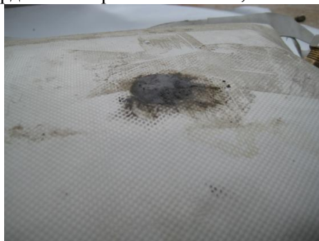
Течь локализована. Происходит отвердевание герметика KR-135
