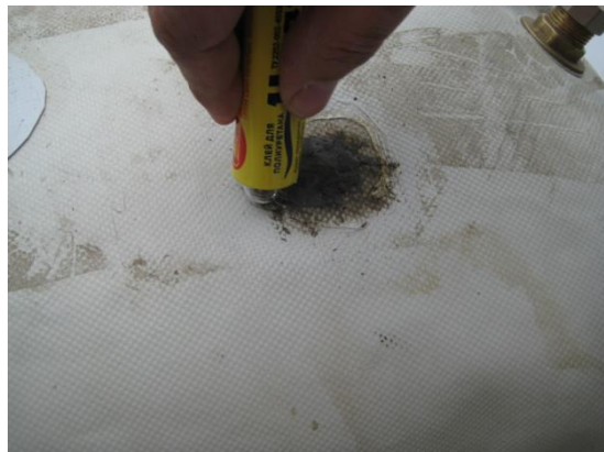
Нанесения клея «Уран» на резервуар
