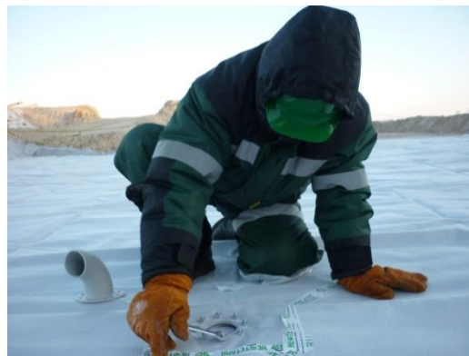
Наворачивание гаек на болты
