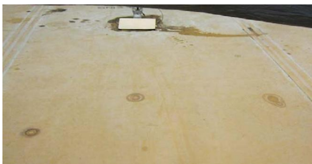
Пример допустимой диффузии в ткани. В результате диффузии на ткани образуются кольца.
