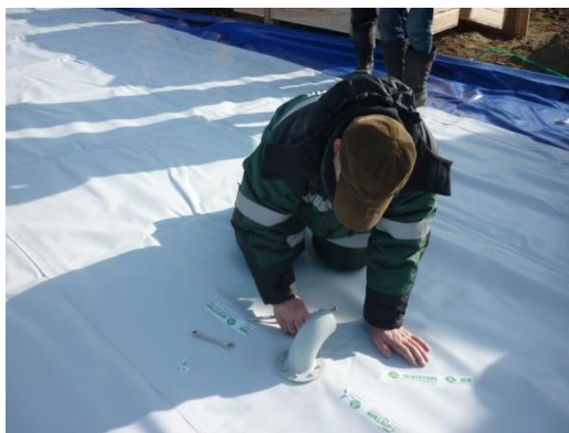
Снятие отвода
