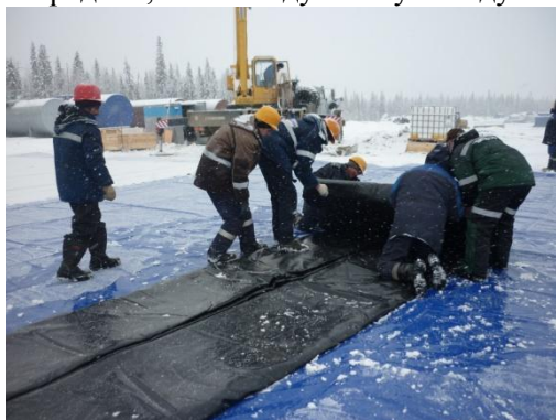
Сворачивание резервуара
