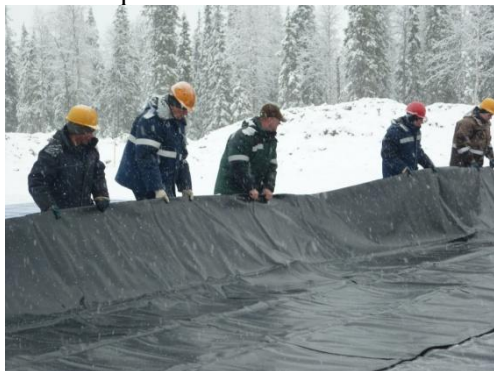
Складывание резервуара
