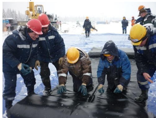
Сворачивание резервуара
